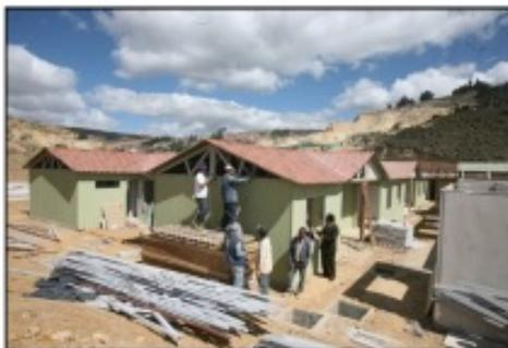
Componentes para cada casa se entrega pre-cortadas y pre-configuradas para el montaje recta hacia adelante en el lugar, reduciendo la necesidad de oficios calificados y eliminar equipos de construcción pesada.
